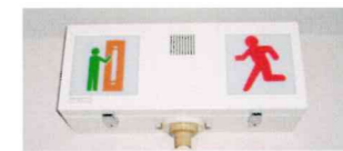
居室に設置されているバトライト。来訪者と緊急時に対応しています。
