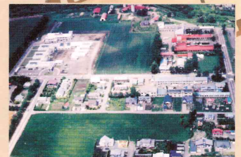
平成8年 旧わかふじ寮取り壊し前の全景
