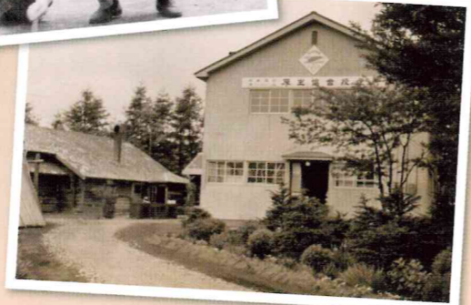
昭和33年お年玉年賀はがきの寄付金を受けて 建設した作業棟
