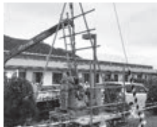
▲ボーリングステップ工法
