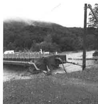
▲神社橋が崩壊し、水道管が破裂
