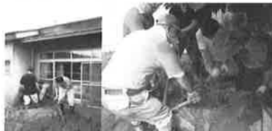
▲住宅敷地内の汚泥かき出し
