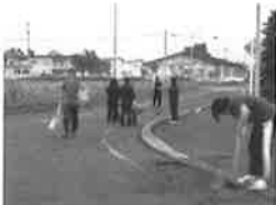
▲施設前道路の小石や 砂利の除去作業
