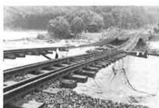
▲JR新得駅近くの鉄橋崩落
