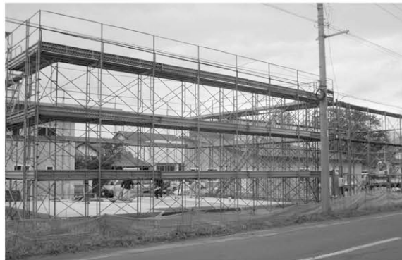
共生型ホームの北側に建設中の職員住宅
