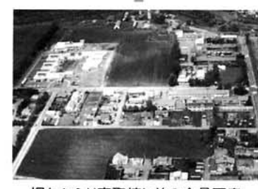
旧わかふじ寮取壊し前の全景写真
