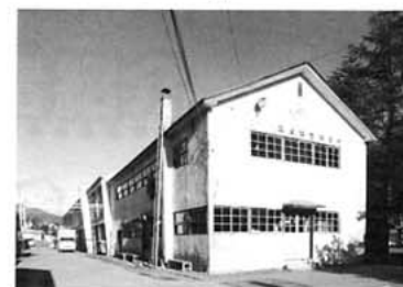
取壊し前のわかふじ寮作業棟
